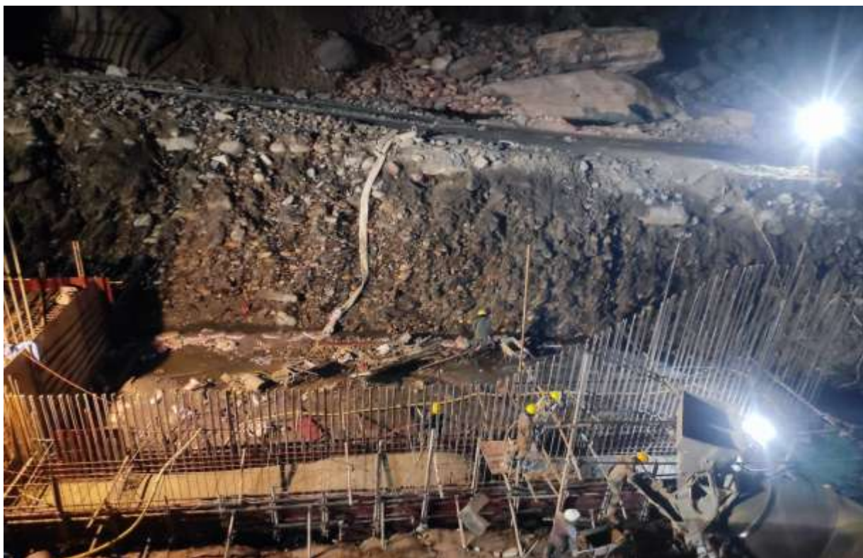
रात्रिकालीन समयमा सिभिल निर्माण कार्य भइरहेको तस्विर
